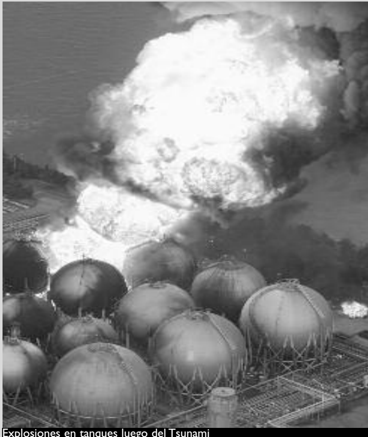
Explosiones en tanques luego del Tsunami
